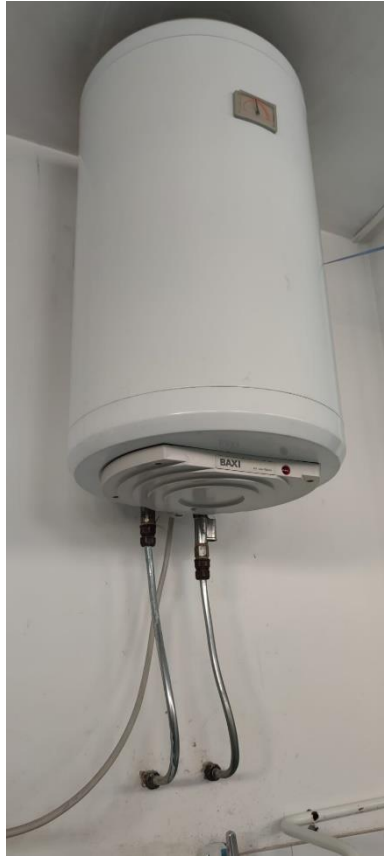
Figura 2 Boiler elettrico per l'ACS
